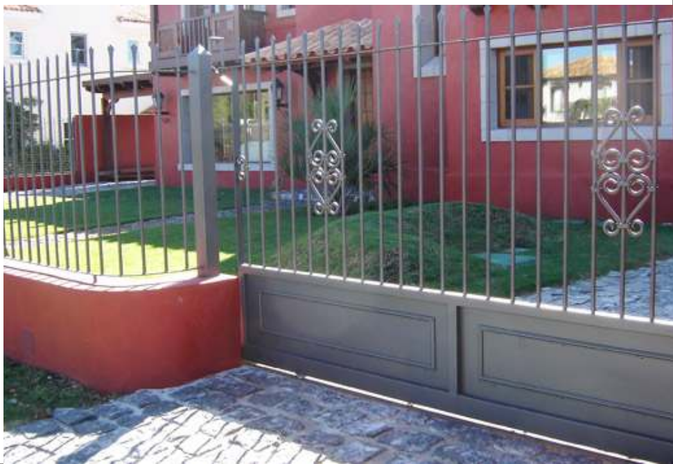
Portón Corredizo con bastidor de chapa y reja
